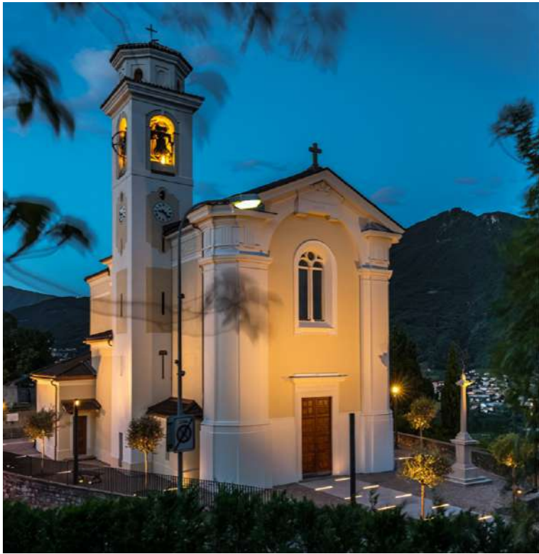
Rif. 1 - Illuminazione della facciata e del fianco
